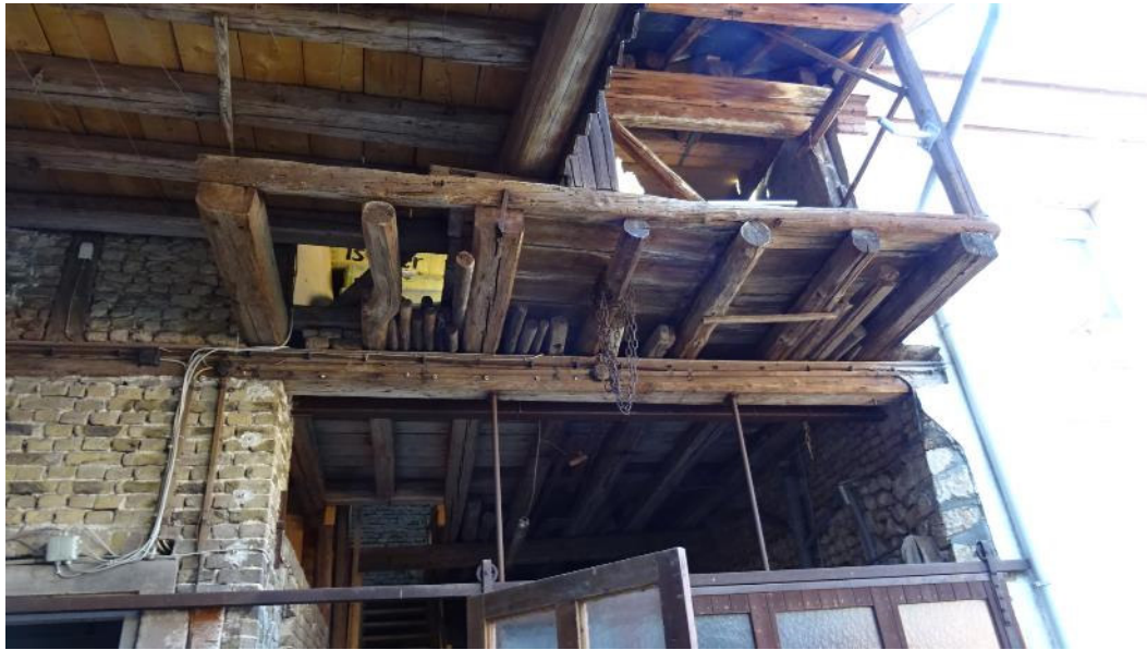
Auskragender Bereich Holzbalkendecke über Foyer
